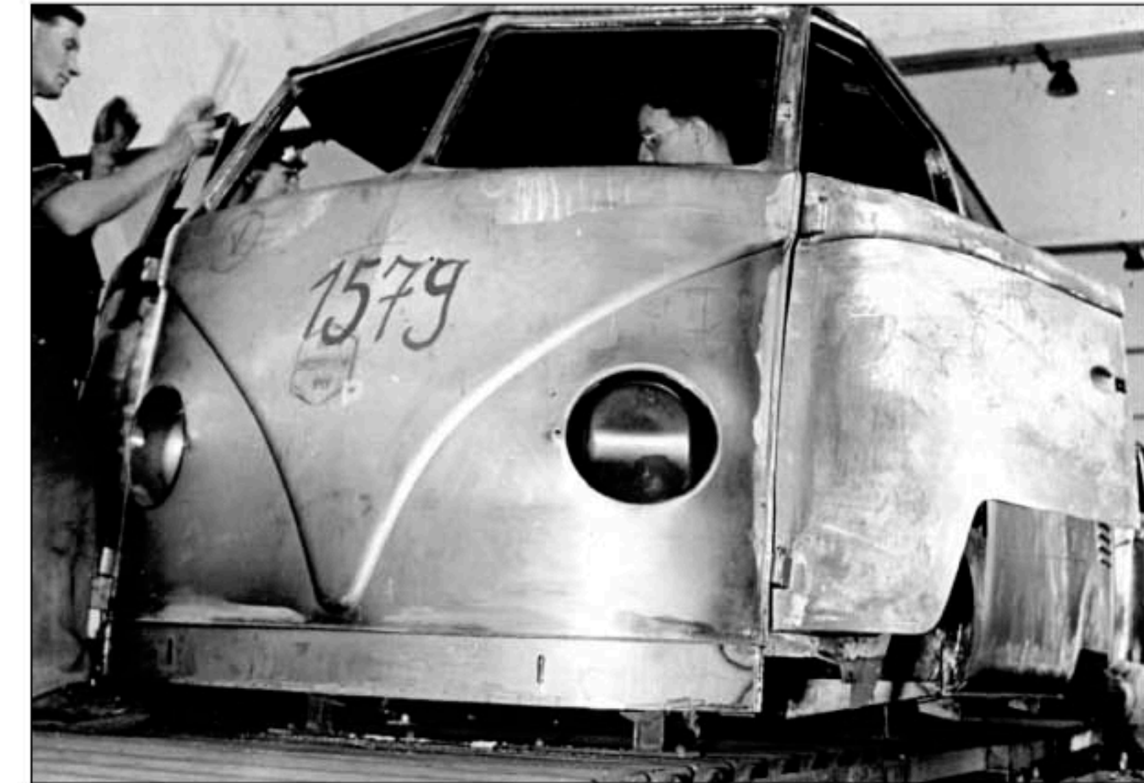
Links (1956): Vor dem Spachteln werden die Bleche sorgfältig geschliffen und notfalls mit dem Hammer nachbearbeitet. Unten: Blick in die Karosserie-montage 1953.
