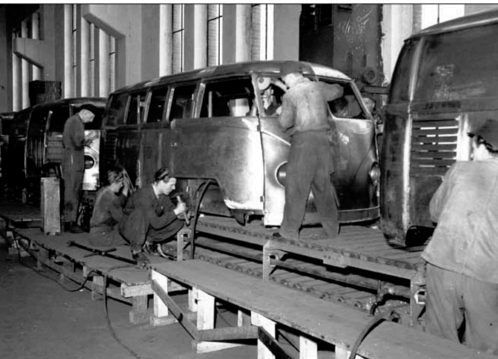
Oben: Aufbaumontage 1953; gut erkennbar: die bereits verspachtelten Punktschweißnähte auf dem Dach. Unten (1954), rechts (1953): Feinarbeit an der Karosserie.
