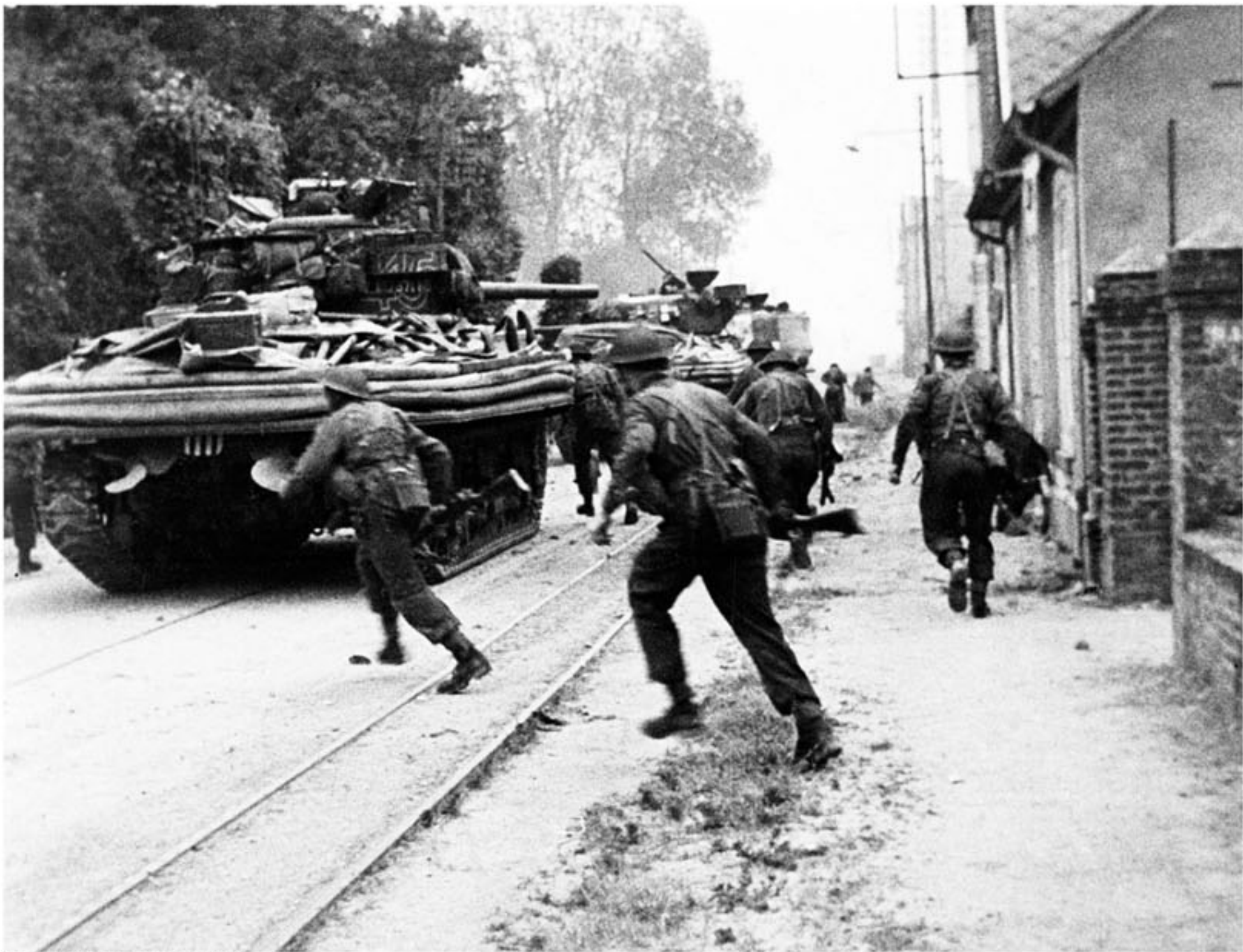
Avant d'arriver à l'angle de la rue Pasteur, les commandos doivent progresser le long de la voie ferrée à l'abri des chars amphibies britanniques Duplex Drive.
